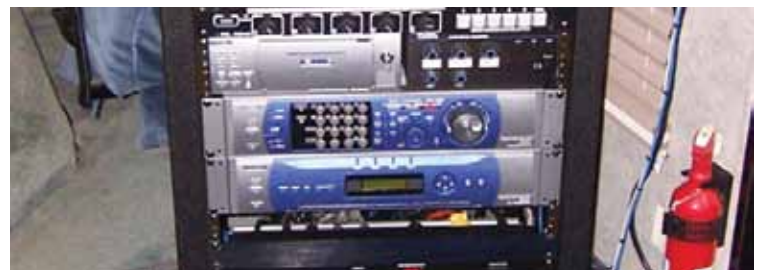
Atlas Rack Loaded with AV Equipment
