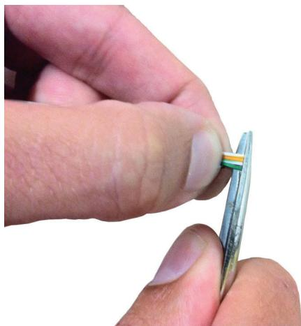
7. Enfiler les fils dans le connecteur RJ45 en les maintenant alignés avec les doigts. La languette du connecteur doit être tournée vers le bas et non visible. La gaine isolante doit arriver juste au bord du connecteur.
