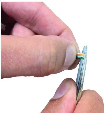
7. Die Adern in den Stecker RJ45 stecken und dabei weiterhin zwischen den Fingern festhalten. Die Lasche des Steckers muss nach unten gerichtet, darf also nicht zu sehen sein. Der isolierende Kabelmantel muss bündig zur Steckerkante abschließen.
